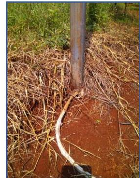
Gambar 46. Kabel masuk ke tiang camera cctv Tdk terbungkus pipa pvc
