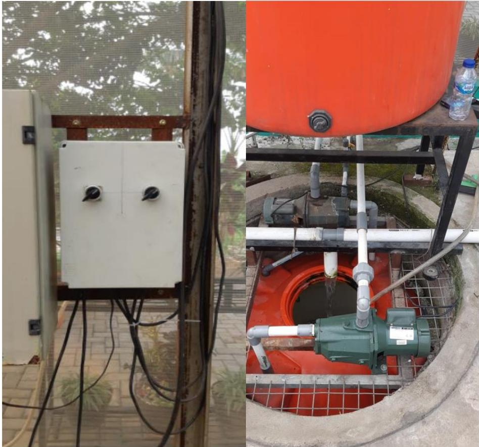
Gambar 54. Penggantian Pompa dan Swich Pompa SGH
