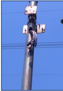
Gambar 47. Kabel masuk ke tiang camera cctv perlu penambahan box converter juga dapat berfungsi sebagai boc
