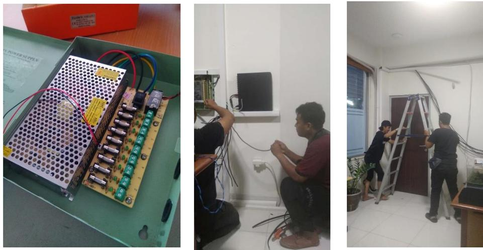
Gambar 51. Penggantian Kabel Indoor CCTV dan Penggantian Video Converter
