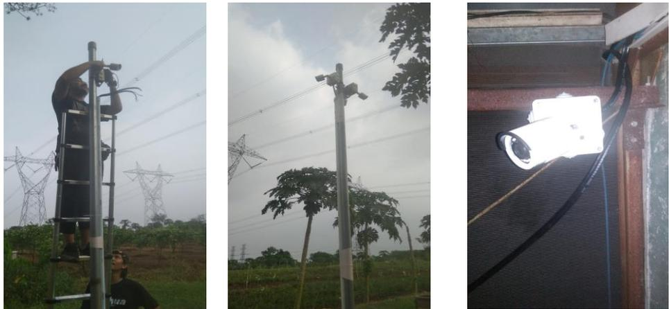
Gambar 48. Penggantian Pipa tiang CCTV, CCTV dan Pemasangan Central Box
