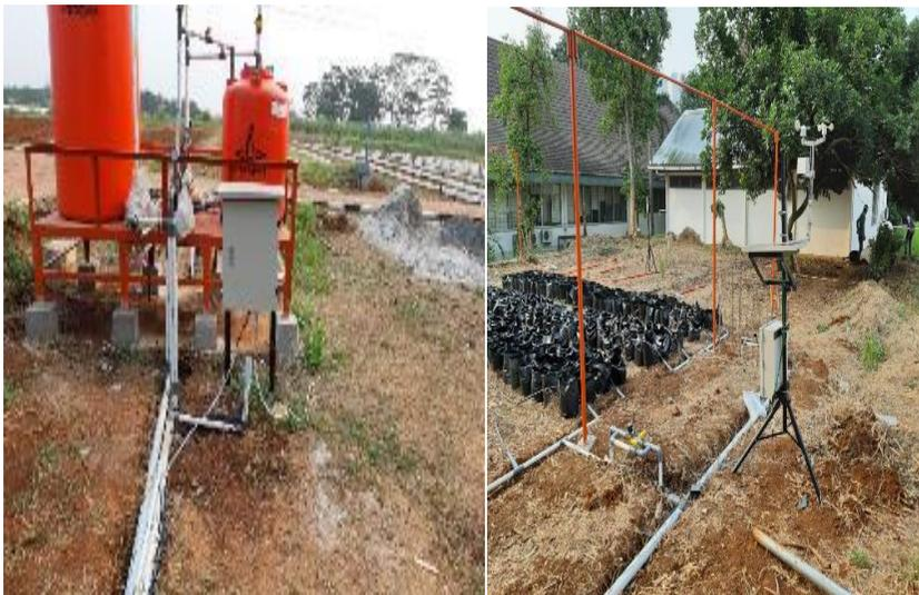
Gambar 7. Perakitan instalasi hardware system sensor tipe A dan Tipe B
