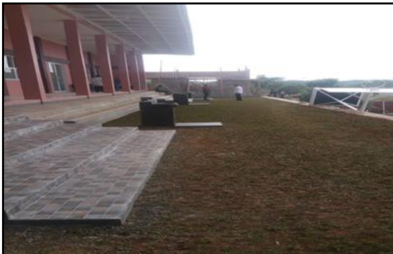
Gambar 24. Pembangunan Pantry dan Gudang serta Fasilitas Pendukung
