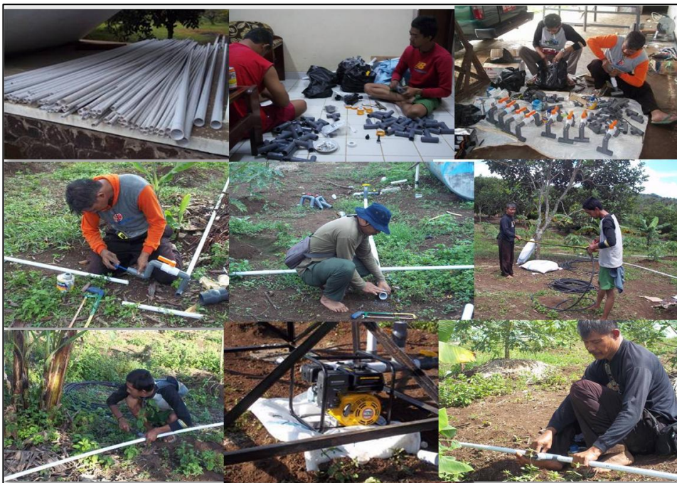
Gambar 20. Proses pemasangan jaringan irigasi tetes di lokasi kegiatan
